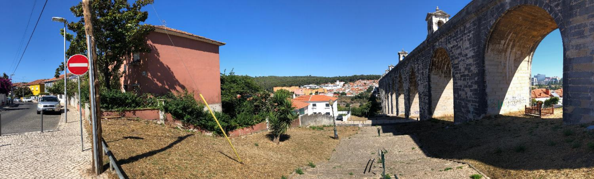
Acueducto Aguas Livres, Valle de Alcántara, Lisboa
